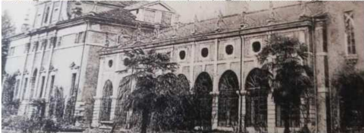
Una foto storica di villa Valle attualmente sede della biblioteca civica. L'originaria dimora dei conti Valle di Vicenza, nel corso di tre secoli, non solo era divenuta un maestoso palazzo nobiliare, ma era riuscita a portare nome all'intera zona
